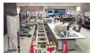
中央監視制御設備据付工事
